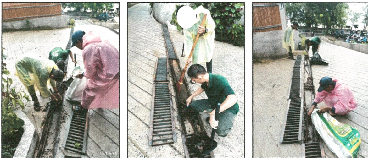
รูปภาพที่ 2.22 การขุดลอกตะกอน
